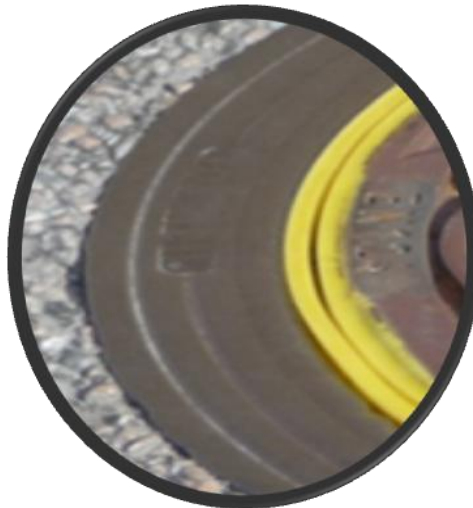
Underhållslock i gammal A6 ram
