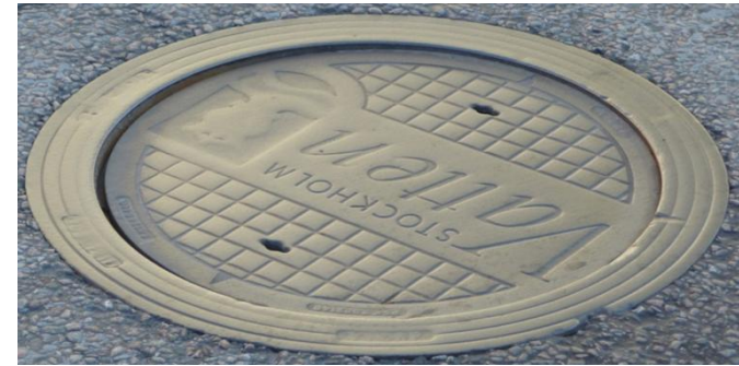
Nerslitet gråjärnslock A6
