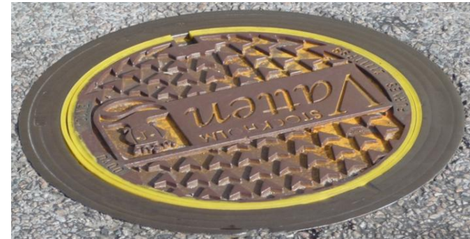
Underhållslock i gammal A6 ram
